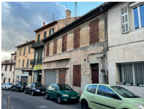
Photographie du bâti dans le noyau villageois des Aygalades
